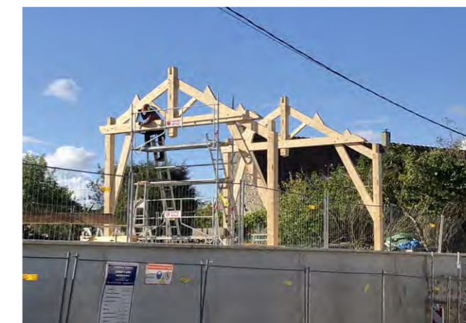
Les charpentiers ont réalisé, sur place, de façon traditionnelle, la découpe et l'assemblage de l'ouvrage sur mesure !
